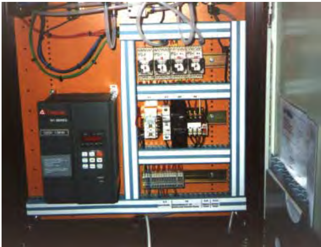
Steuerschrank mit Frequenzumrichter
