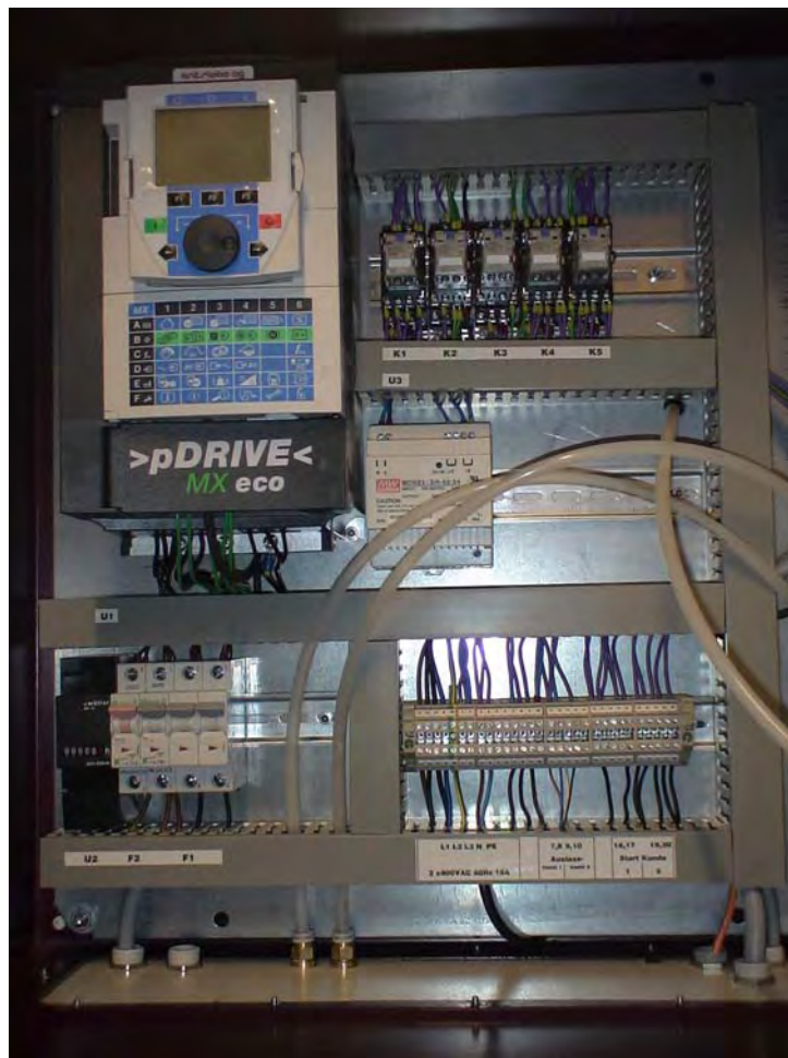
Steuerschrank mit Frequenzumrichter
